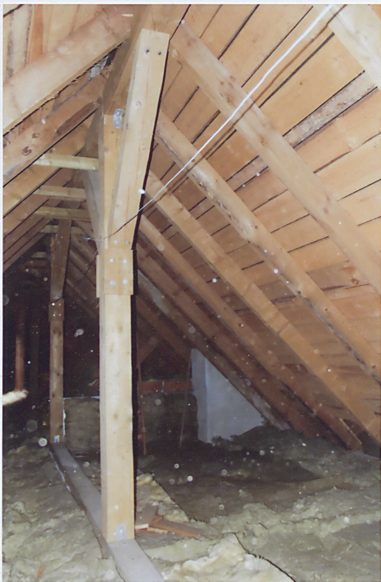
Fot.8 Wieżba dachowa z elementami konstrukcyjnymi
