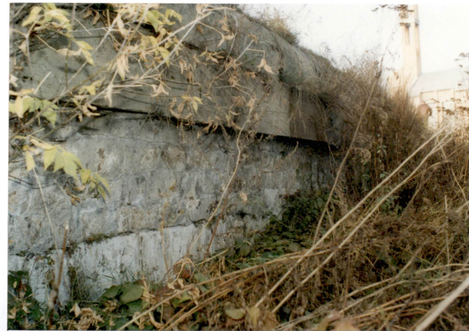
6. Ściana przelewu od strony niecki wypadowej, widoczna czapa z dużych ciółów piaskowcowych i nawis czapy w postaci kapinosa, neg. 500/558/6.
