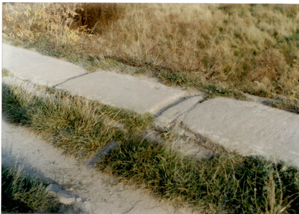
3. Fragment progu przelewowego - korona z płyt kamiennych spajanych lanym żeliwem, neg. 500/558/3.
