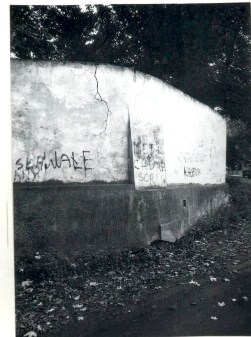
fragment muru z na- rożnym wzmocnieniem szkarpą
