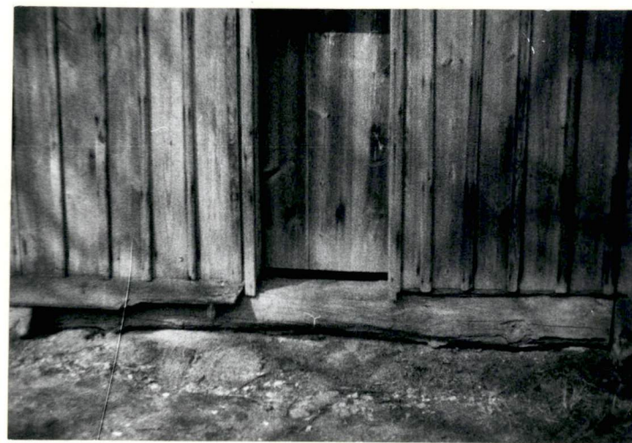
Belka podwaliny i wejście do wnętrza dzwonnicy / ściana wschodnia /
