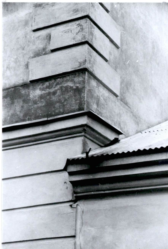
Fragment elewacji zachodniej - boniowanie (nr neg.128/36)
