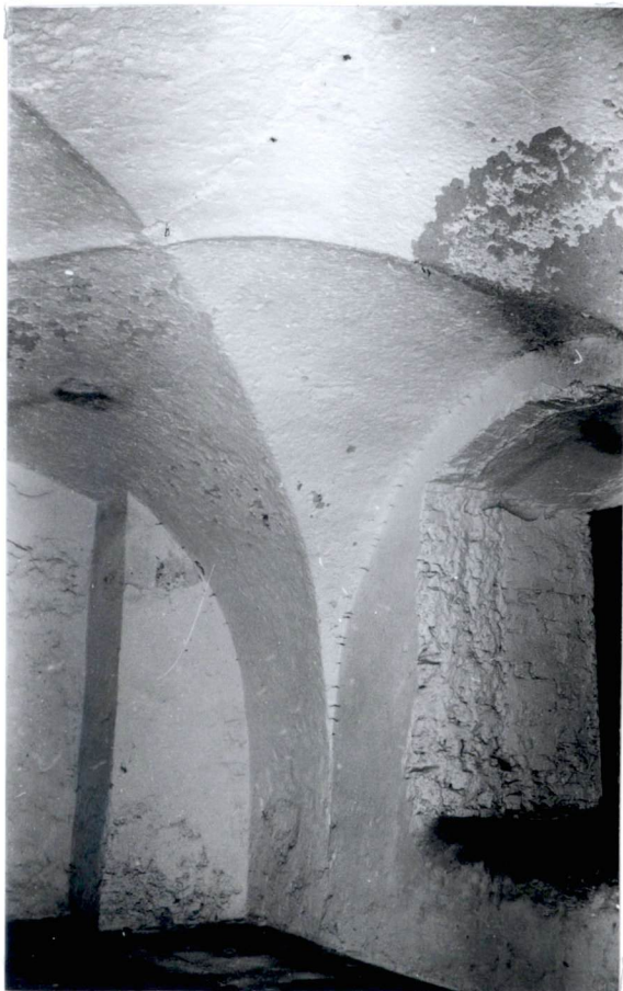
Fragment pomieszczenia nr 3 - sklepienie krzyżowe (nr neg.124/36)
