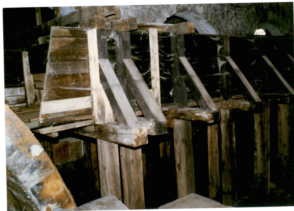
4. Koryto drewniane doprowadzające wodę na koło wodne napędzające niegdyś walcownię, neg. 500/946/5.
