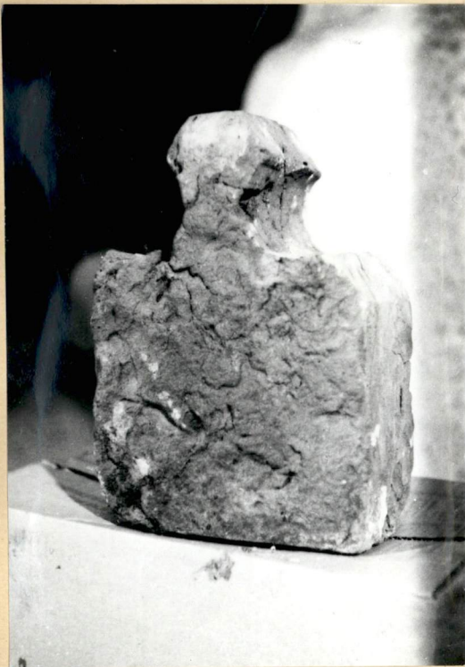
19. Gótycka cegła formowana (prawdopodobnie z żeber sklepiennych d. kapituława umiejscowionego przy kościele)
