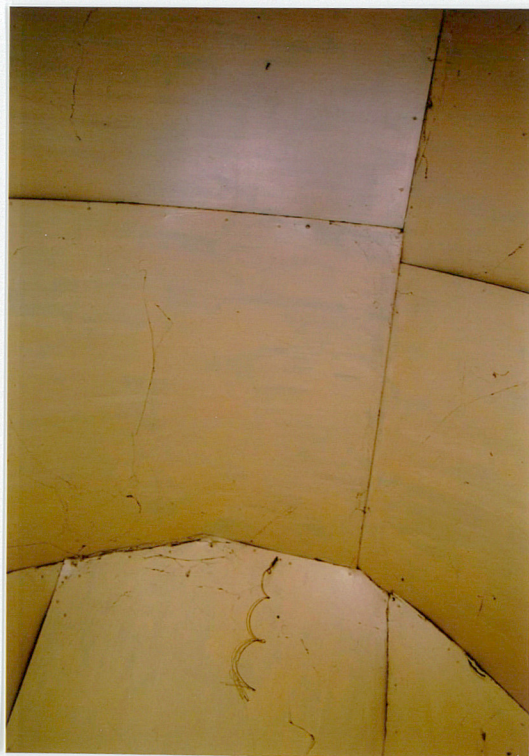
8. Kaplica drewniana, sklepienie obite wtórnie płytą pilśniową, ul. Morawska, Racibórz.
