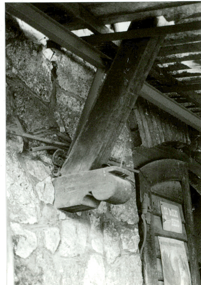
Fragment belkowania szczytu (profilowana belka wspornikowa).
