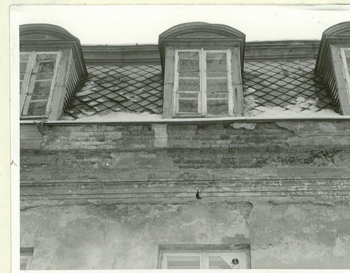
Uszkodzenia tynków
