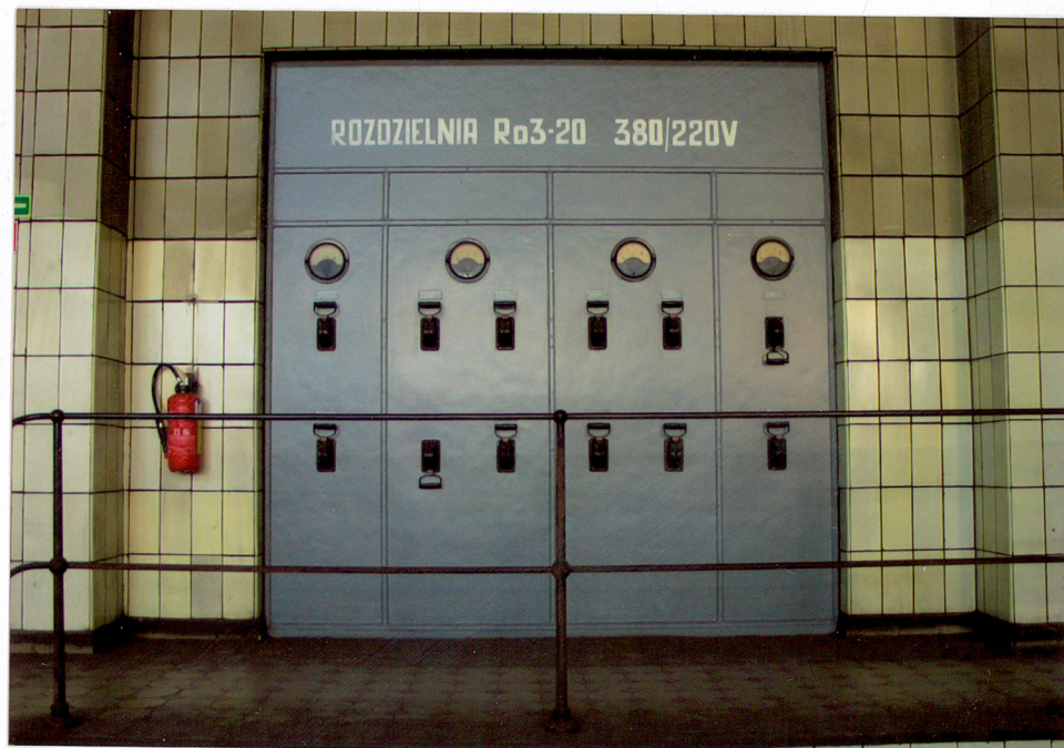
Widok szafy rozdzielnic Ro3-20
