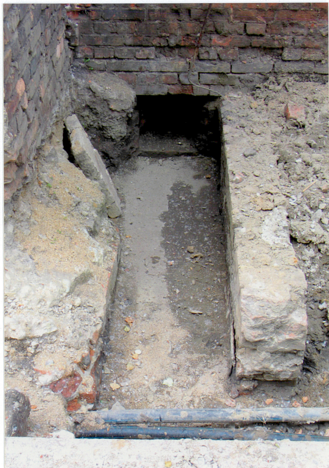
ZEWNĘTRZNY ODCINEK KANAŁU KABLA ZASILAJĄCEGO
