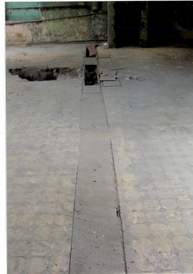
WEWNĘTRZNA TRASA KANAŁU KABLA ZASILAJĄCEGO (ODCINEK W OSI ŚRODKOWEJ)
