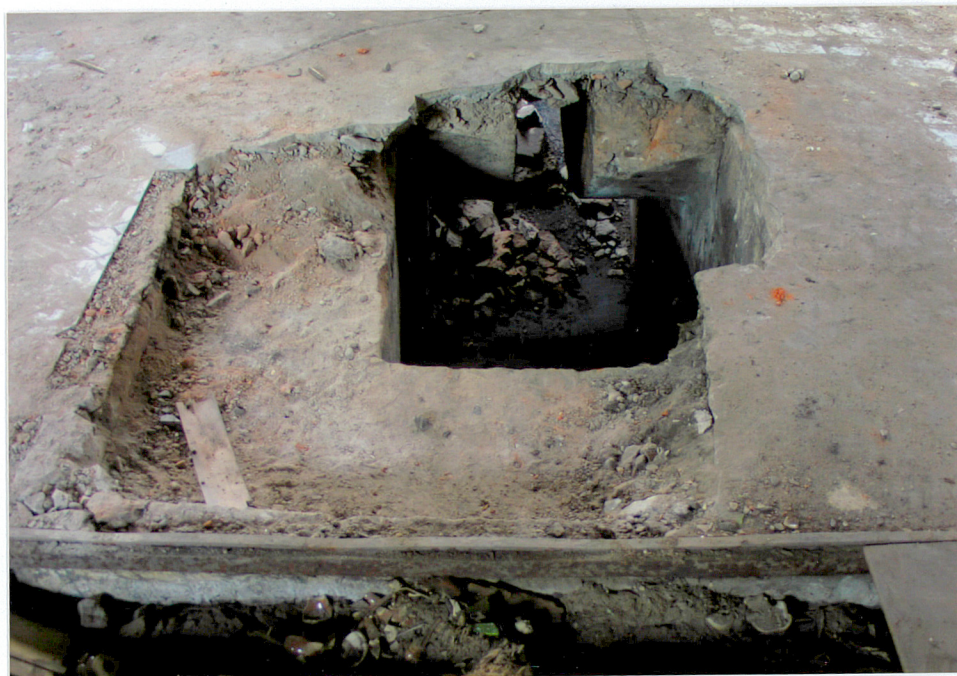
WIDOK KANAŁU WENTYLATORA PROMIENIOWO-ODŚRODKOWEGO W BUDYNKU
