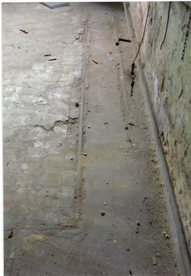
WEWNĘTRZNA TRASA KANAŁU KABLA ZASILAJĄCEGO (ODCINEK PRZY ŚCIANIE POŁUDNIOWEJ)
