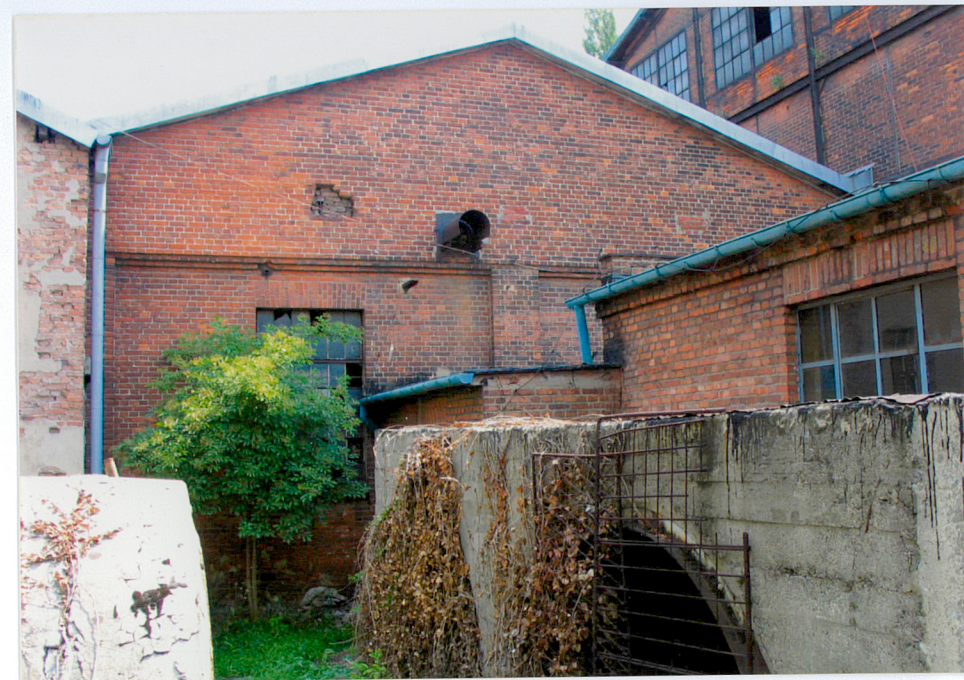
ELEWACJA ZACHODNIA BUDYNKU STAREGO WENTYLATORA ORAZ KANAŁY WENTYLATORA „JOY” ŚCIANA PÓŁNOCNA BUDYNKU SILNIKÓW I SZAFY PRZYLĄCZY WENTYLATORÓW „JOY”
