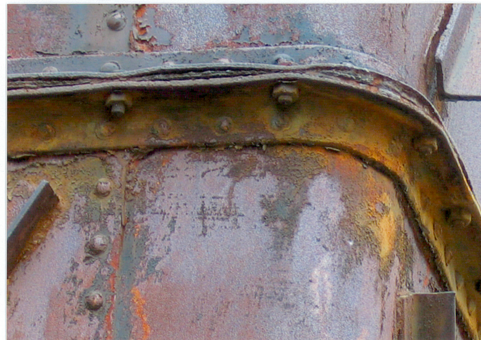
FRAGMENT POŁĄCZEŃ NA STALOWEJ OBUDOWIE DYFUZORA
