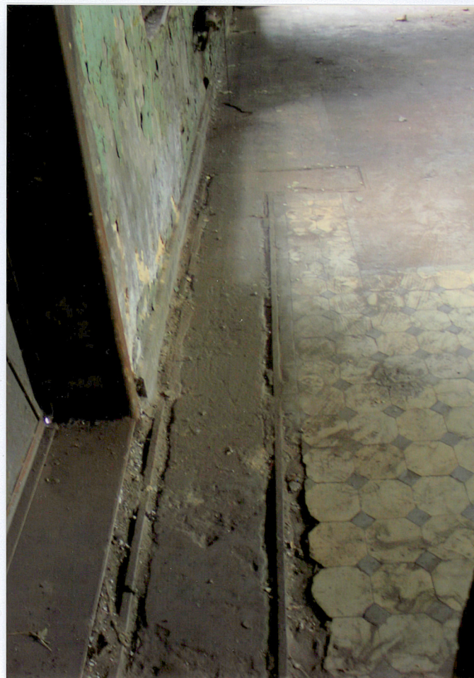
WEWNĘTRZNA TRASA KANAŁU KABLA ZASILAJĄCEGO (ODCINEK PRZY ŚCIANIEWSCHODNIEJ)
