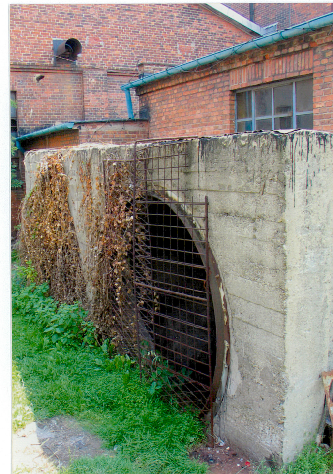
WYLOTY KANAŁÓW WENTYLATORÓW „JOY” OD STRONY BUDYNKU SILNIKÓW I SZAFY PRZYŁĄCZY
