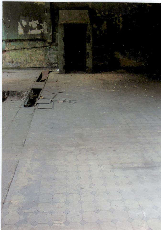
WEWNĘTRZNA TRASA KANAŁU KABLA ZASILAJĄCEGO (ODCINEK W OSI ŚRODKOWEJ ORAZ MIEJSCE SILNIKA ZAPASOWEGO)
