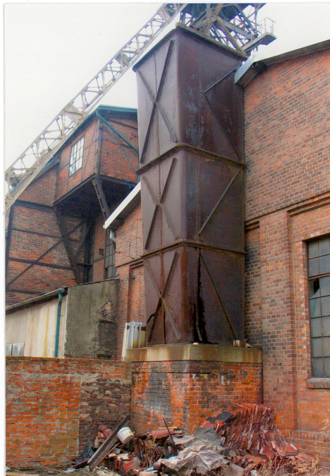
ELEWACJA WSCHODNIA Z DYFUZOREM PIERWSZEGO WENTYLATORA
