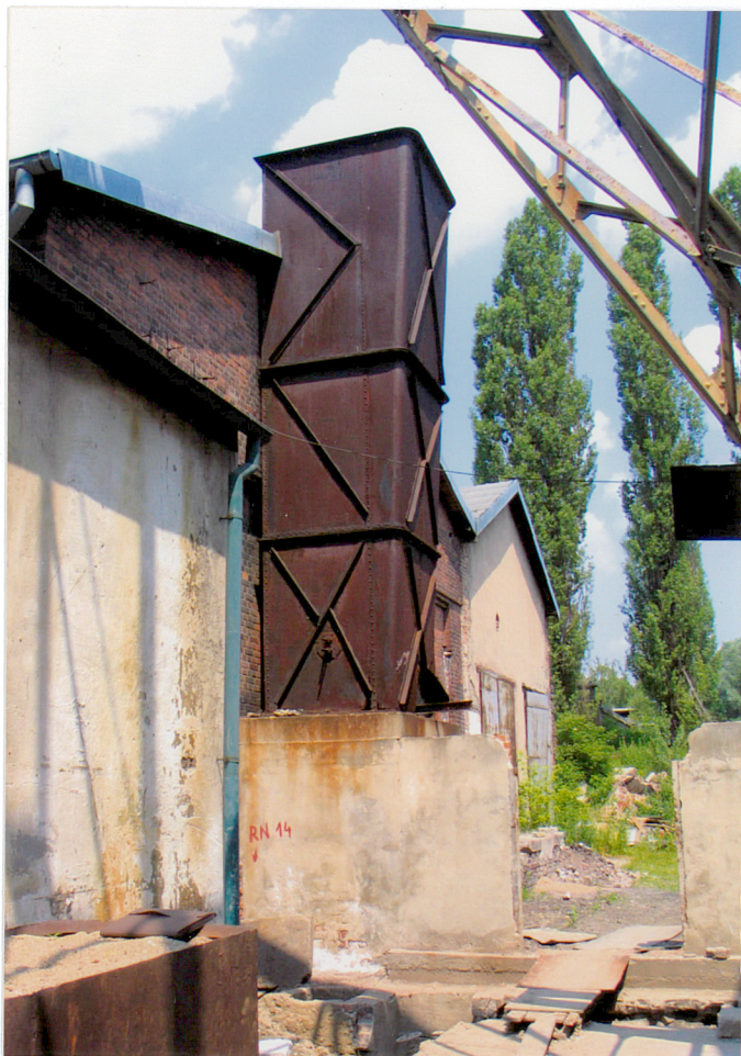
ELEWACJA WSCHODNIA Z DYFUZOREM PIERWSZEGO WENTYLATORA
