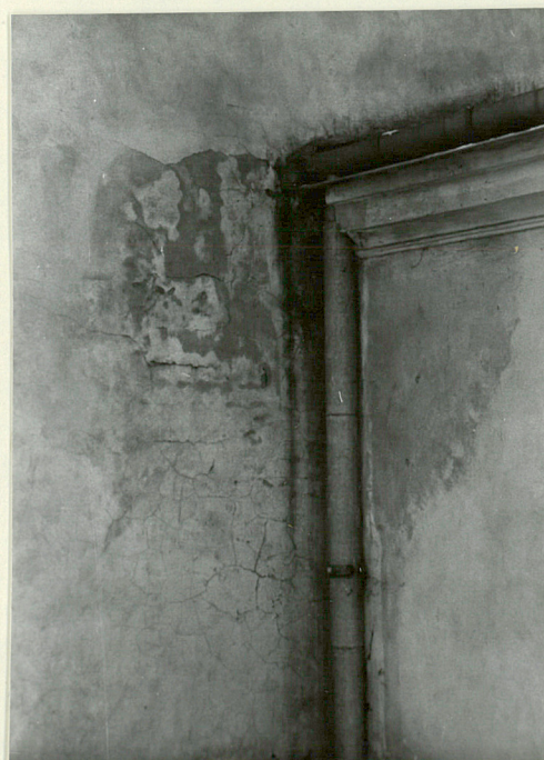
WIDOWISKO ZAWILGOCENIE NA ŚCIANIE KAPLICY POŁNOCCY
