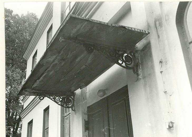
WSPORNIKI PODTRZYMUJĄCE ŻADASZENIE NAD WEJŚCIEM GŁÓWNYM.
