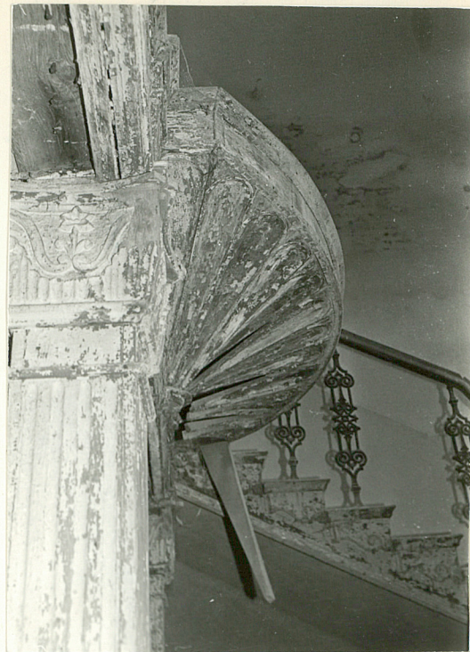
PÓŁKOLISTY WYSTĘP POWAD KLATKĄ SCHODOWĄ, WRAZ Z SŁUPKIEM WSPIERAJĄCYM KONSTRUKCJĘ.
