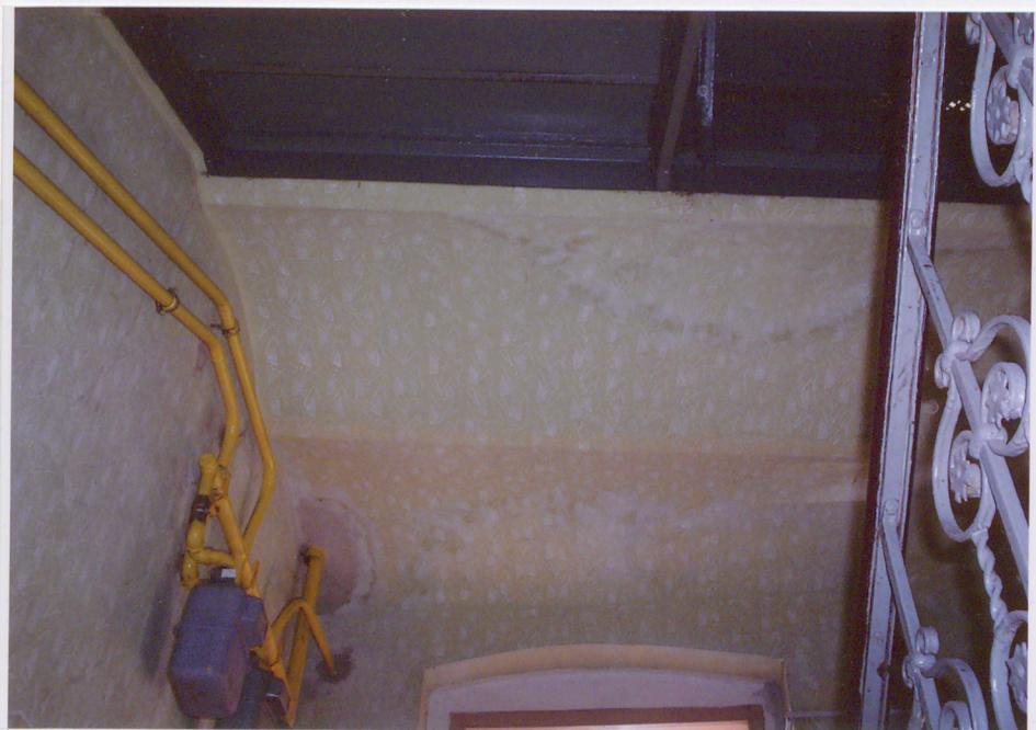
Fot. 27. Strop Kleina nad schodami w klatce schodowej budynku głównego.
