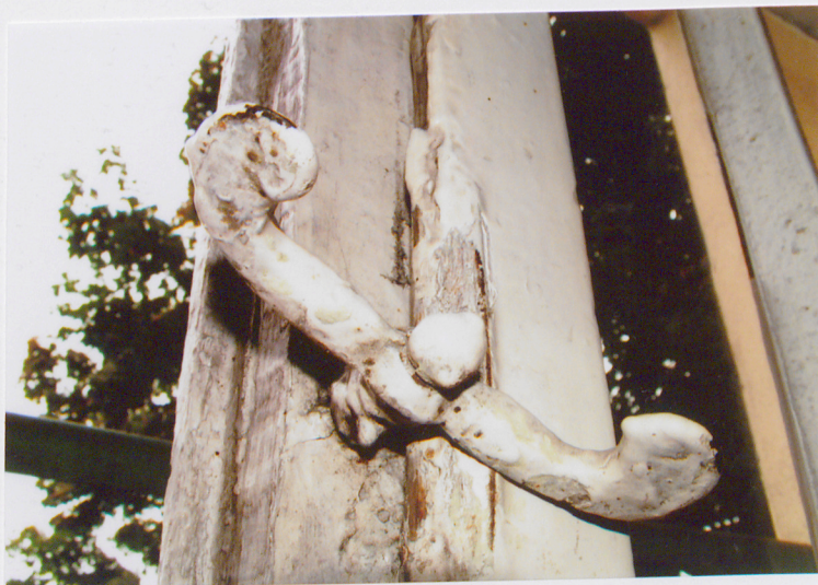
8. Zakrętka dwuskrzydłkowa w okien klatki Schodowej, ul. Fryderyka Chopina 11, Racibórz.
