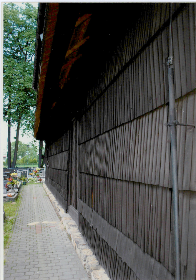
Fot.9. Szalowanie w obrębie elewacji południowej.
