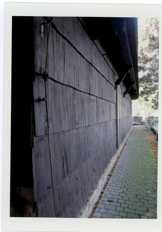
Fot.10. Szalowanie w obrębie elewacji północnej.
