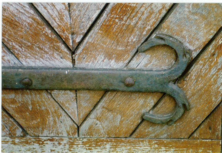
7. Zawias polski pasowy w drzwiach wejściowych, ul. Basztowa, Racibórz
