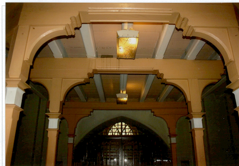
Fot. 22. Drewniane belki konstrukcji chóru.
