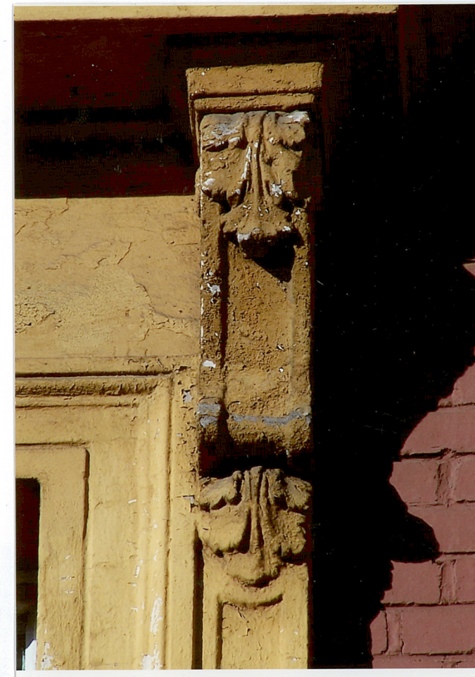
Fot.7. Pierwsze piętro elewacji wschodniej od ulicy Sienkiewicza. Detal konsolki podtrzymującej naczółki otworów okiennych z motywami liści akantu.
