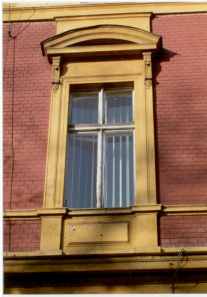
Fot.5. Pierwsze piętro elewacji wschodniej od ulicy Sienkiewicza. Detal obramienia otworu okiennego.
