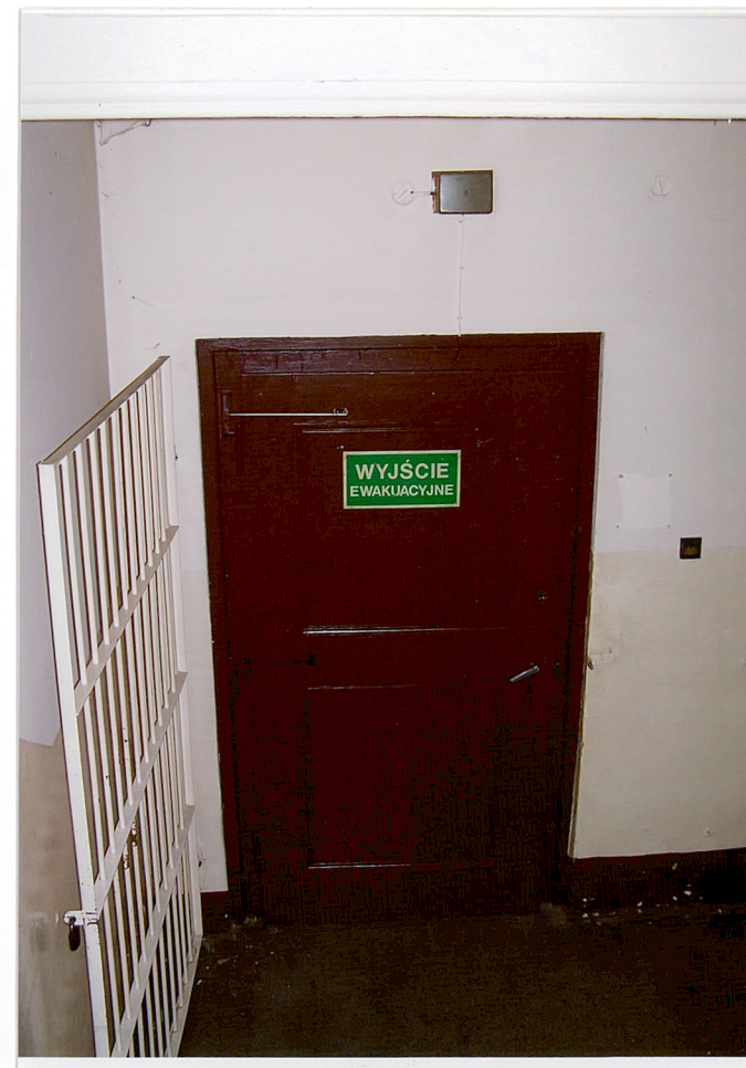
Fot.27. Detal drewnianych, jednoskrzydłowych, pływiniowych drzwi prowadzących na zewnątrz budynku. (wyjście boczne).
