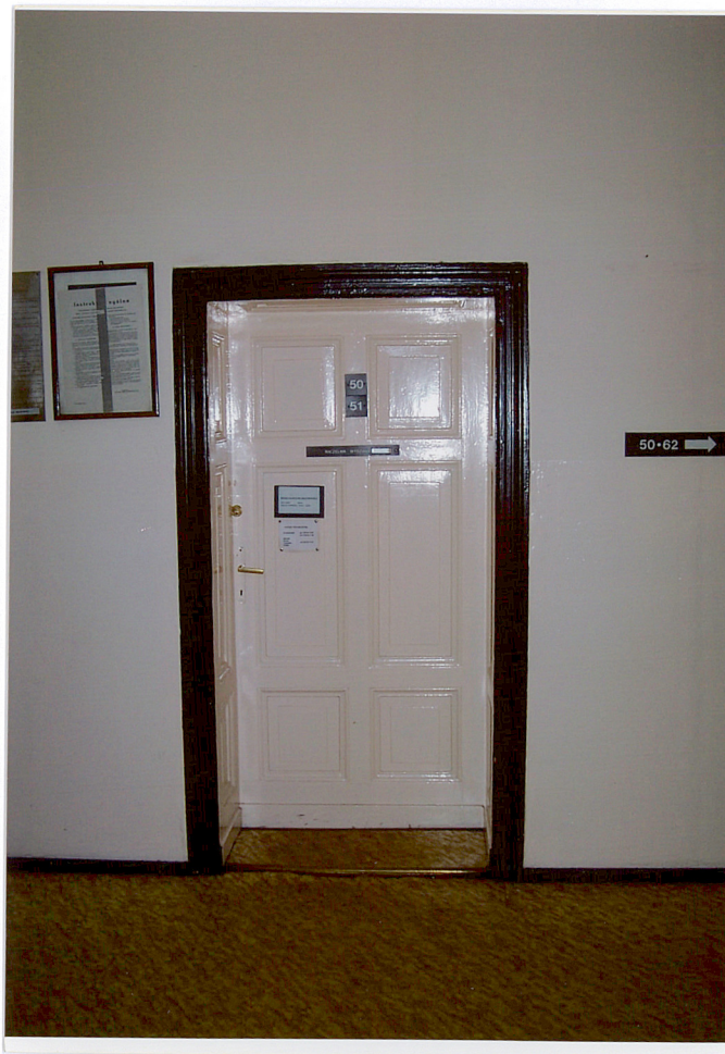
Fot.26. Detal drewnianych, jednoskrzydłowych, pływiniowych drzwi wewnętrznych.
