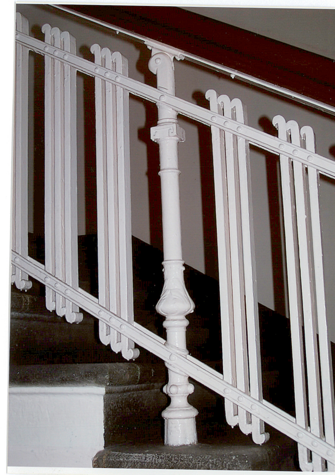
Fot.24. Detal balustrady klatki schodowej prawego skrzydła budynku. Balustrada metalowa z pionowym podziałem traiek.
