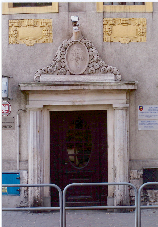
Fot.4. Zbliżenie portalu wejściowego elewacji frontowej w osi budynku. Kolumny kaneluowane doryckie z belkowaniem, ponad rzeźbiarski, owalny kartusz opleciony różami, wypełniony inicjałami.
