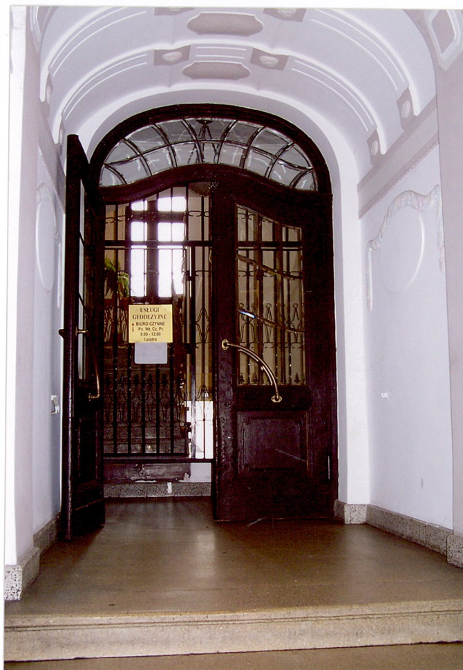
Fot.15. Detal stolarki drzwiowej przedsionka na parterze kamienicy. Drzwi dwuskrzydłowe, drewniane, częściowo przeszklone, z nadświetłem.
