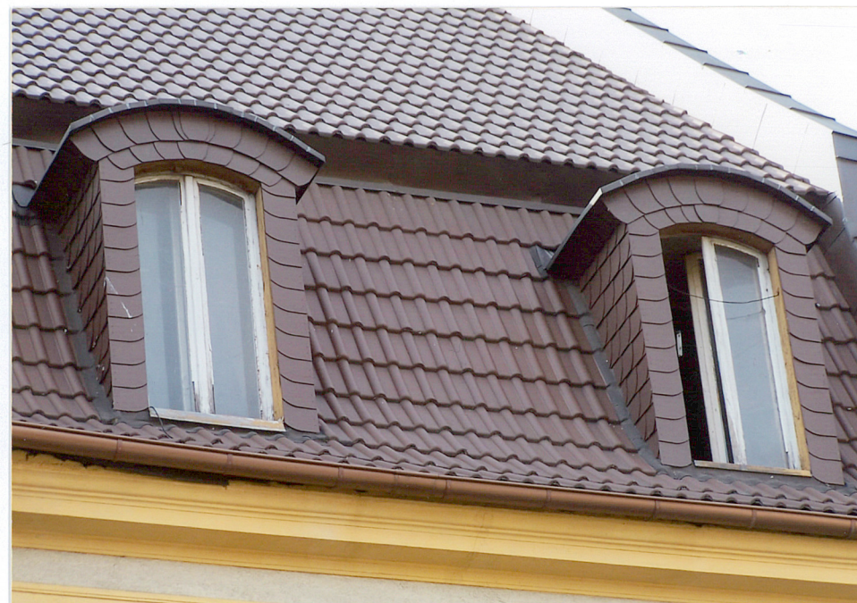
Fot.11. Lukarny łukowe w dachu elewacji frontowej.
