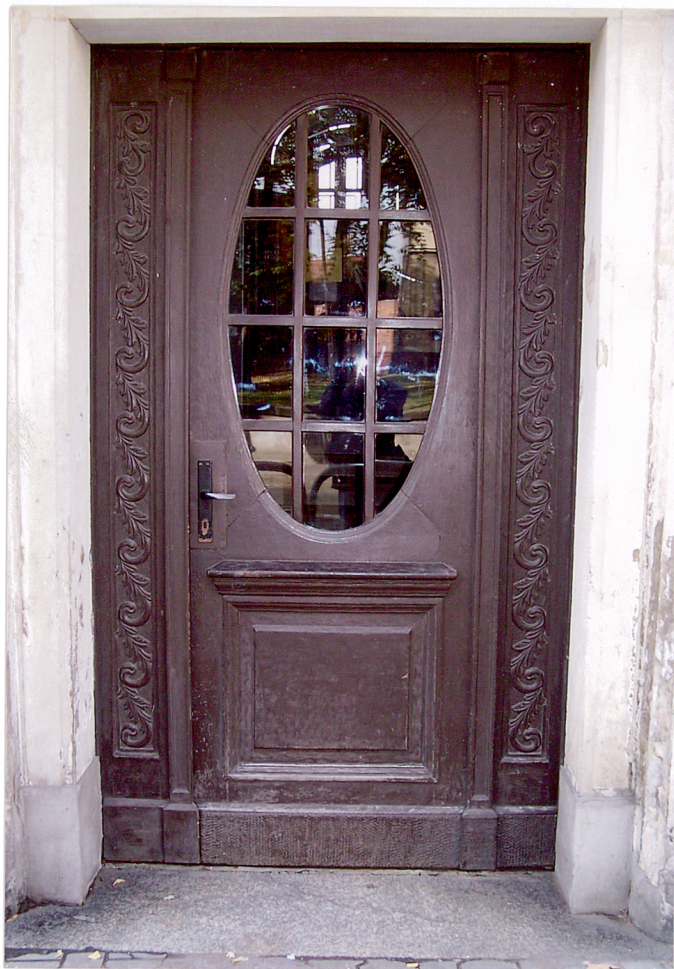
Fot.14. Detal stolarki drzwiowej głównego wejścia do budynku. Drzwi płycinowe, drewniane, z przeszkleniem, po bokach ozdobny ornament roślinny (tzw. arabeska).
