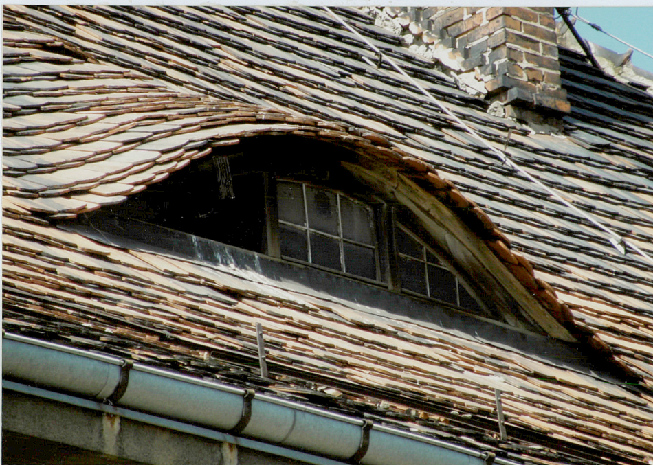
9 – ELEWACJA WSCHODNIA, OKNO TYPU „POWIEKA”
