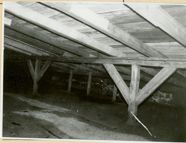
Słodownia wieżba dachowa
