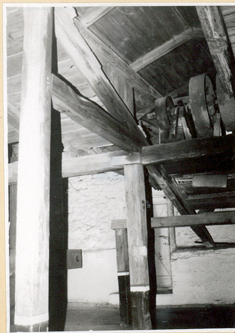
Słodownia konstrukcja dachu
