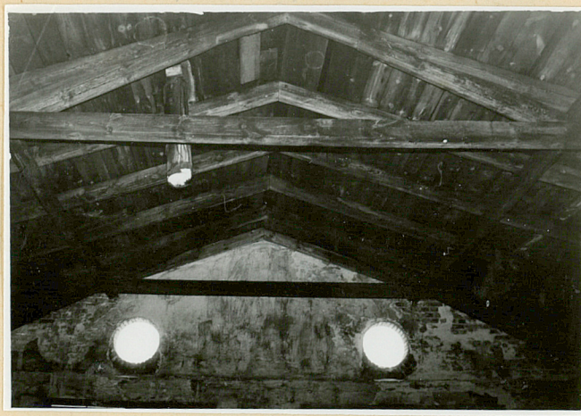
Maszynownia wieżba dachowa
