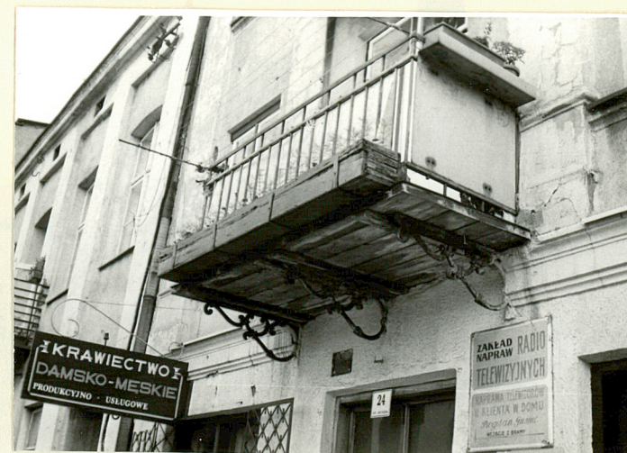
DREWNIANY BALKON NA STĄDOWYCH WSPORNIKACH OD RYNKU
