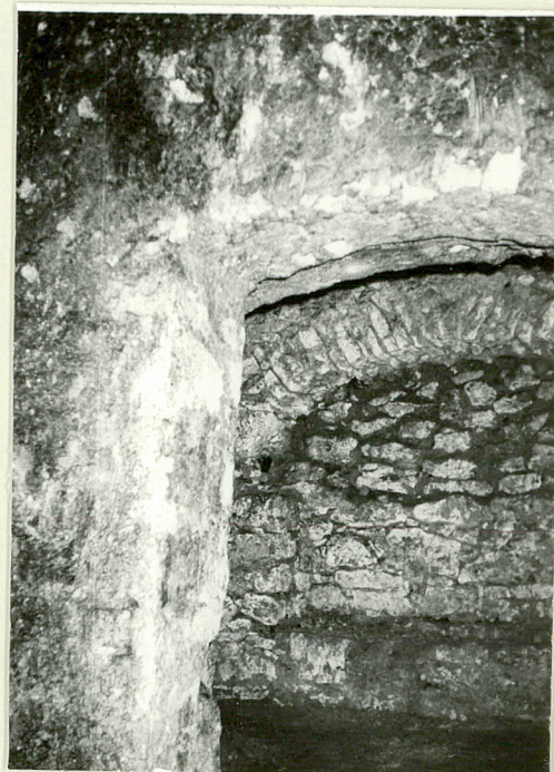
LICZNE PRZEMUROWANIA ŚCIAN PIWNIANYCH WIDOCZNE W GŁĘBI
