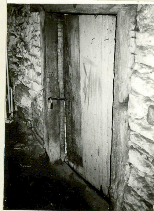
DRZWI DESKOWE DO JEDNEJ Z PIWNIC Z BELKAMI DREW. JAKO RAMA
