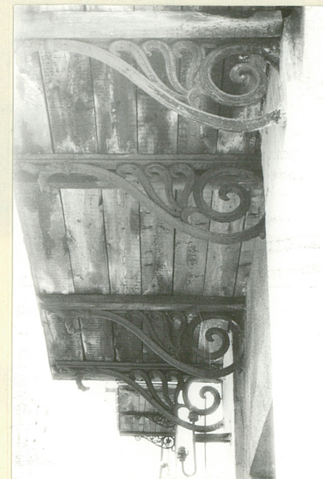
Wsporniki balkonu - detal
