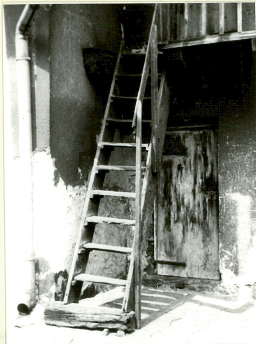
Schody drabiniaste prowadzące na galerię przy budynku gospodarczym
