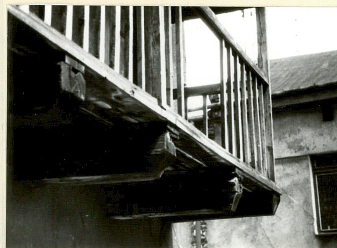
Detal galerii - belki z balustradą
