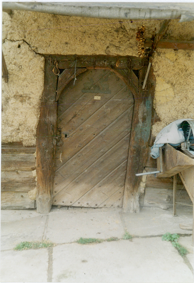
Elewacja wschodnia. Wejście. Na nadprożu wycięta data "1841". Węgary i nadproże z drewna iglastego. Zastrzały narożne nadproża podcięte dla stworzenia owalnego zamknięcia otworu. Drzwi drewniane, podwójne. Szalowane skośnie. Ozdobne, kute gwoździe.
