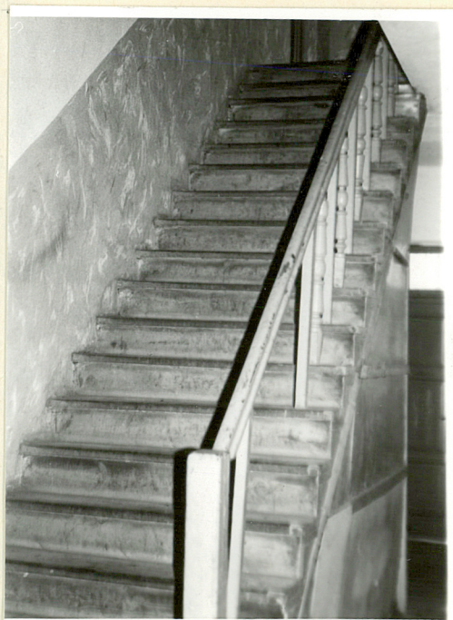
DREWNIANE SCHODY Z BALUSTRADĄ TRĄLKOWĄ PROWADZĄCE NA I PIĘTRO
