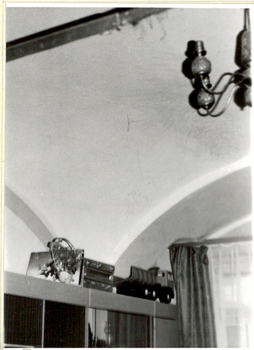
DETAL SKLEPIENIA ŻAGIELKOWEGO
