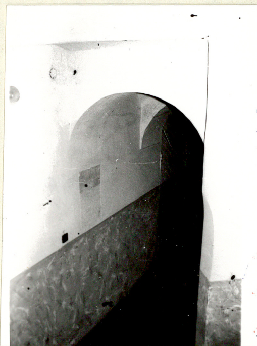
SIENĆ PRZEJŚCIOWA Z WIDOCZNYM SKLEPIENIEM ŻAGIELKOWYM
