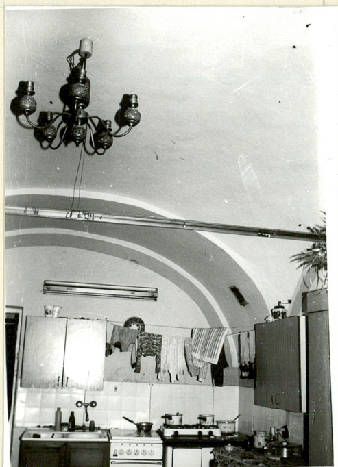
SKLEPIENIE ŻĄGIELKOWE WZMOCNIONE ELIPTYCZNYMI ŁĘKAMI W POMIESZCZENIU MIESZKALNYM NA PARTERZE
