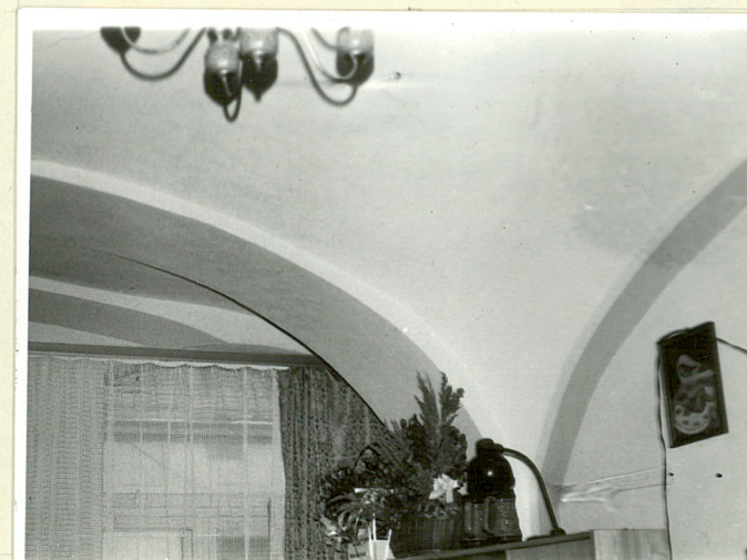
FRAGMENTY SKLEPIENIA ŻAGIELKOWEGO W JEDNYM Z POMIESZCZEŃ MIESZKALNYCH NA PARTERZE
