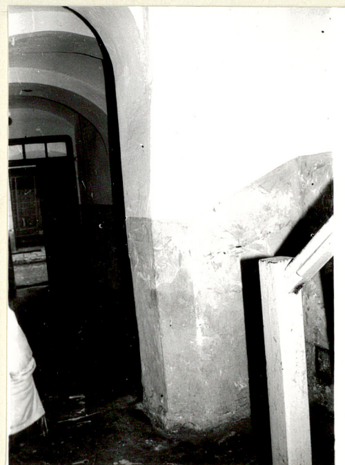
SIENĆ PRZEJŚCIOWA Z WIDOCZNYM SKLEPIENIEM ŻAGIELKOWYM
