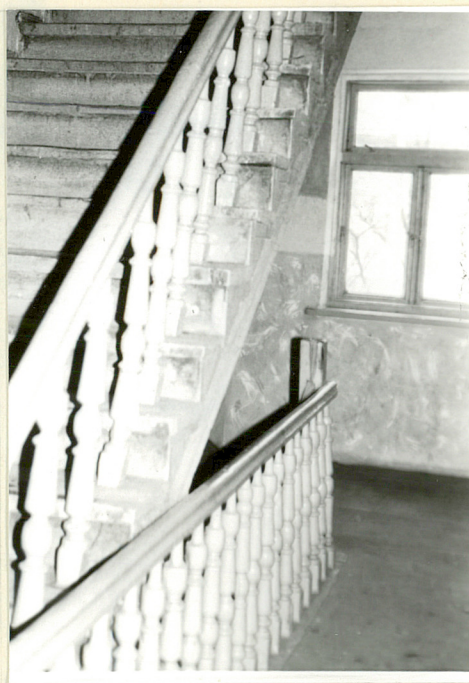
SCHODY DREWNIANE Z BALUSTRADĄ TRĄLKOWĄ ŁĄCZĄCE I II KONDYGNACJĘ
