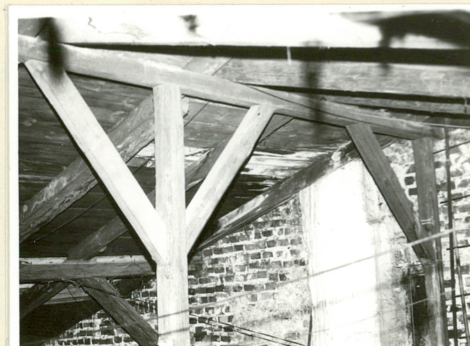
ELEMENTY KONSTRUKCJI WIĘŻBY DACHOWEJ
