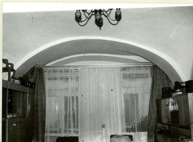
FRAGMENTY SKLEPIENIA ŻAGIELKOWEGO W JEDNYM Z POMIESZCZEŃ MIESZKALNYCH NA PARTERZE
