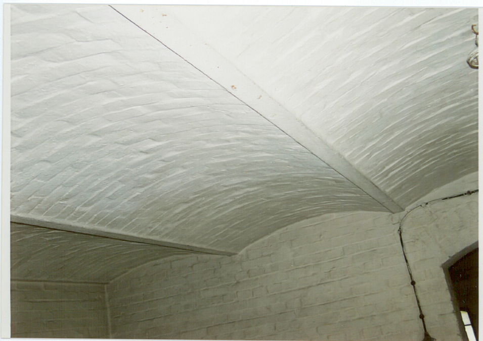
Fot. 29. Sklepienia odcinkowe Kleina w klatce schodowej.
