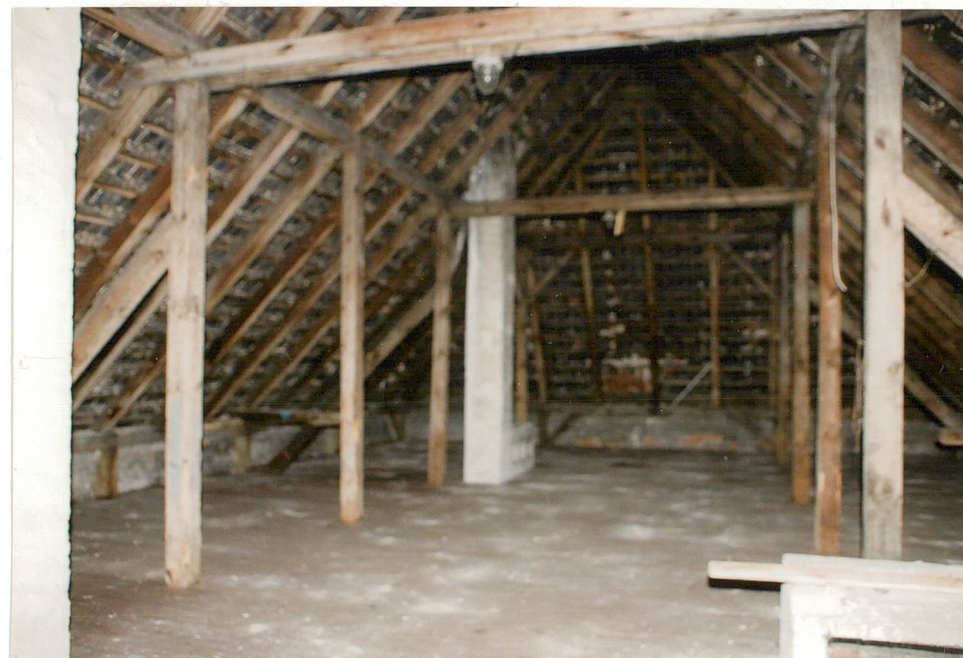
22.,23. Widoki więźby dachowej.
