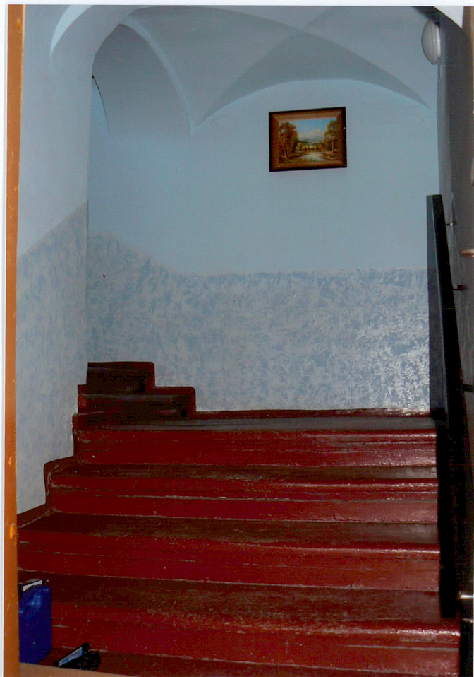
Fot. 5. Fragment klatki schodowej z sklepieniem klasztornym.
