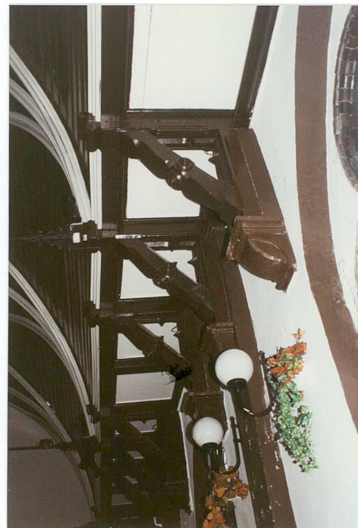
53. Konstrukcja wsporcza sklepienia pozornego w auli.
