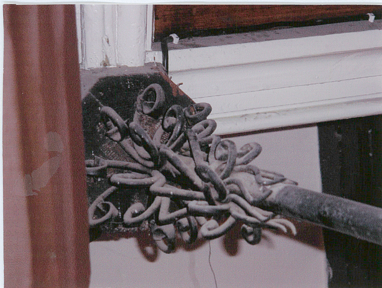
50. Dekoracyjne zakończenie stalowego ściągu.
