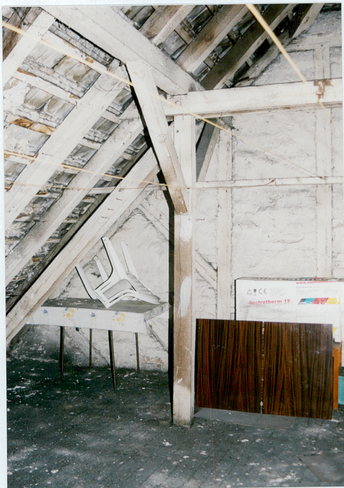
Fot. 26. Więźba dachowa.
