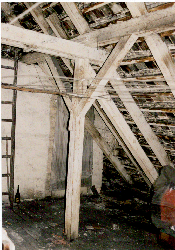
Fot. 31. Fragment więźby dachowej.
