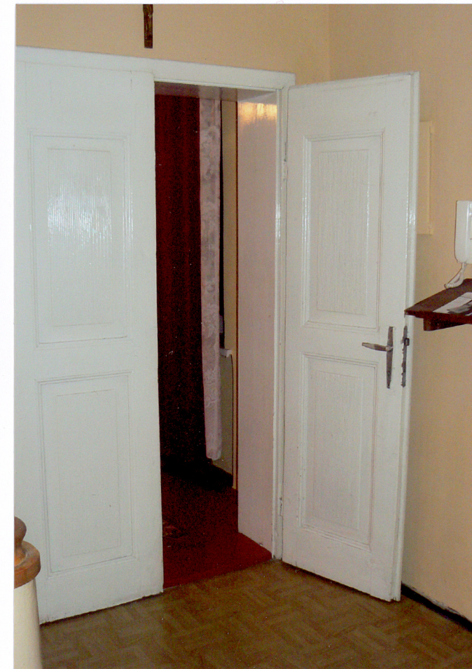
Fot. 3. Przykład stolarki drzwiowej typowej dla większości otworów drzwiowych wnętrza. Sień pierwszego piętra.
