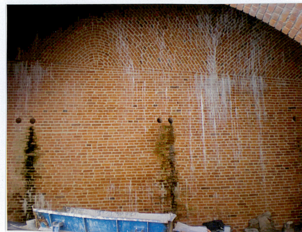
Otwarty łuk odciążeniowy, w murze bastionu
