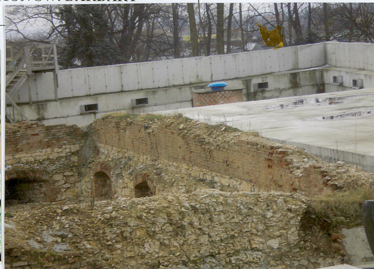
Bark pn-wsch. nowego bastionu Widoczne wzmocnienie styku ścian barku i czoła
