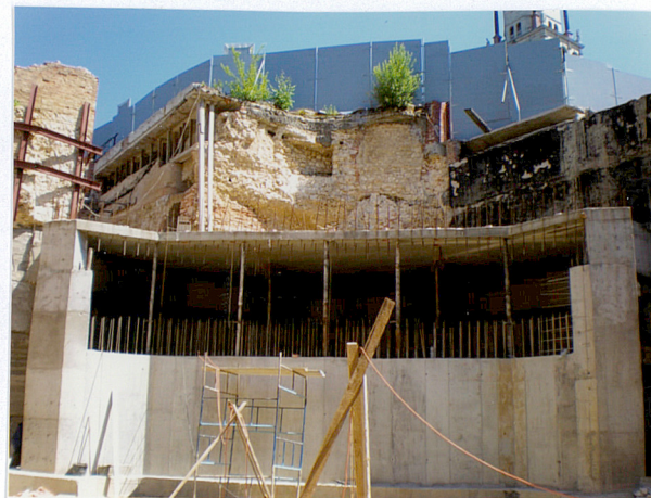
Stary bastion. Żelbetowa platforma w szyi bastionu
