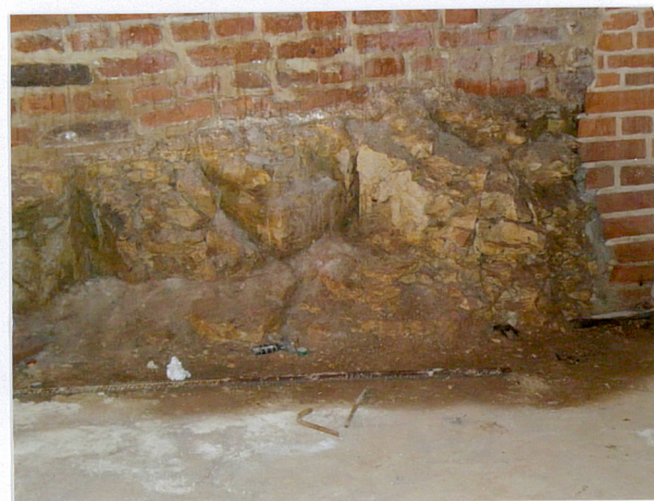
Posadowienie murów bastionu nowego. Widoczne partie skały wapiennej
