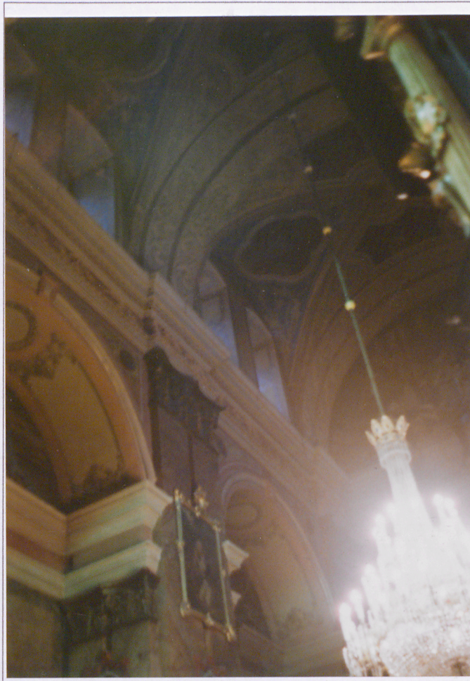
SKLEPIENIE NAWY KOLEBA Z LUNETAMI I GURTAMI
