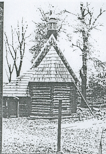
Ściany kościółka przed pokryciem gontami
