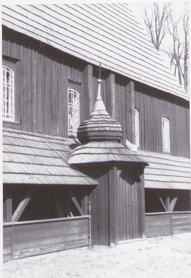
Fot. 5 - fragment elewacji południowej z bramką i sobotami oszalowanymi do połowy wysokości
