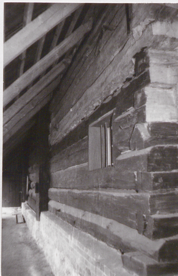
Fot. 9 - fragment ściany wieńcowej na podmurówce kamienno-ceglanej pod sobotami
