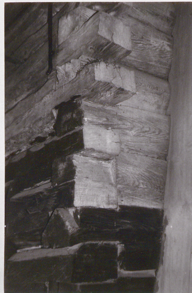
Fot. 10 - zwęgłowanie kościoła na nakładkę
