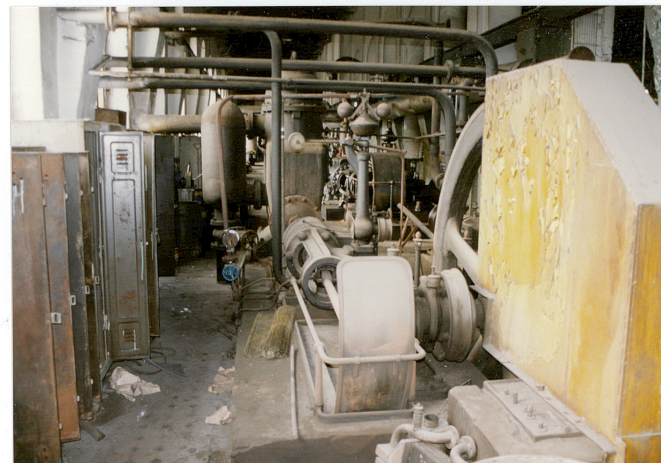
Pompa parowa kondensatu w hali maszyn
