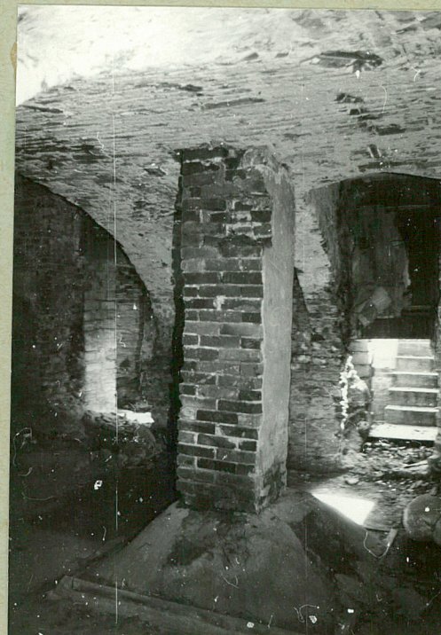
FILAR ZE STOPĄ FUNDAMENTOWĄ W PIWNICY OD STRONY PARKU W KORPUSIE
