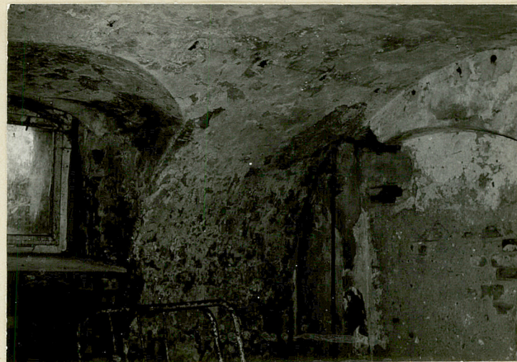
18. SKŁĘPIENIE Z LUNETĄ W TRAKCIE WSCHODNIM PIWNICY
