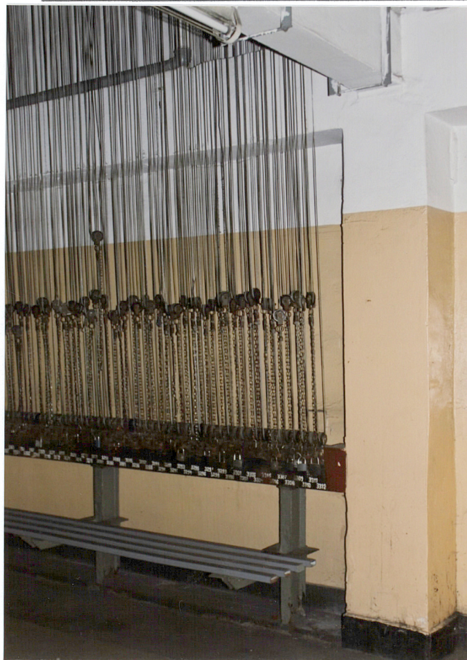
16.,17.,18. Mechanizm łańcusków na bloczkach do podwieszania haków na ubrania.
