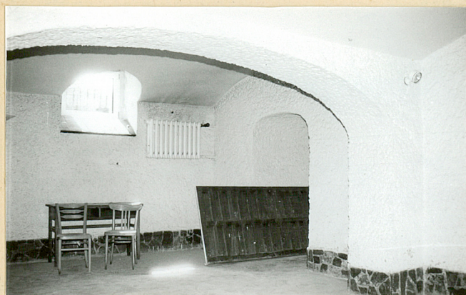
Sklepienia nad salą kameralną w piwnicy
