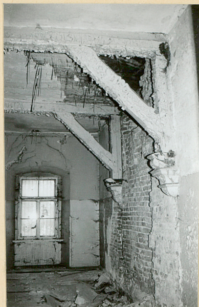
Konstrukcje drewniane dźwigające strop nad piętrem
