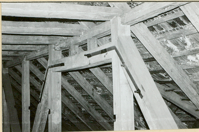
Konstrukcja wieszarowa w ścianie stolcowej w górnym pasie dachu mansardowego
