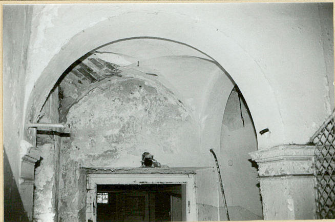
Sklepienie krzyżowe w klatce schodowej
