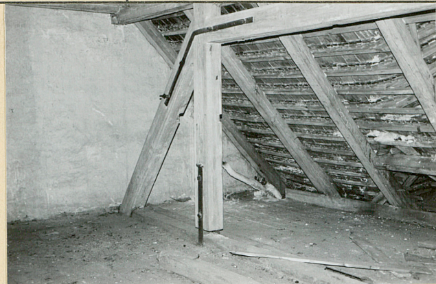
Konstrukcja wieszarowa w ścianie stolcowej w górnym pasie dachu mansardowego
