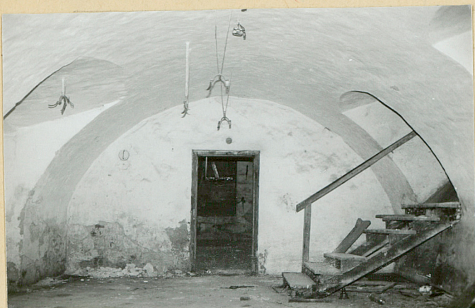
Sklepienia w pomieszczeniach piwnicznych w północnej części budynku
