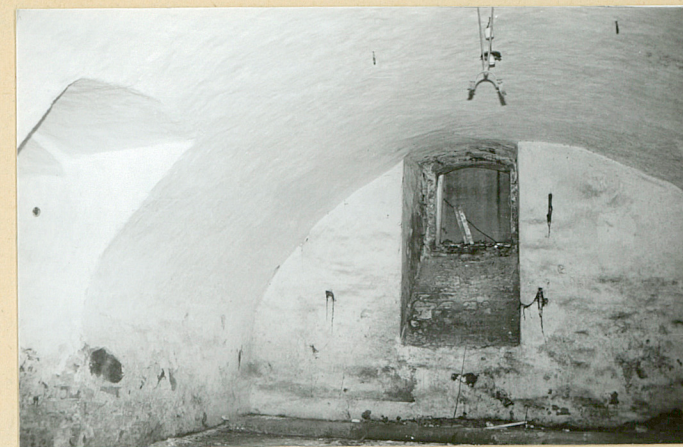
Sklepienia w pomieszczeniach piwnicznych w północnej części budynku
