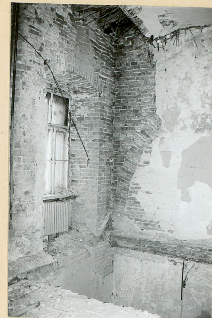
Zdemontowany frag. stropu nad parterem
