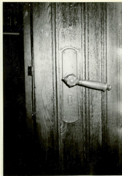
OKUCIA DRZWI WEJŚCIOWYCH ZEWNĘTRZNYCH
