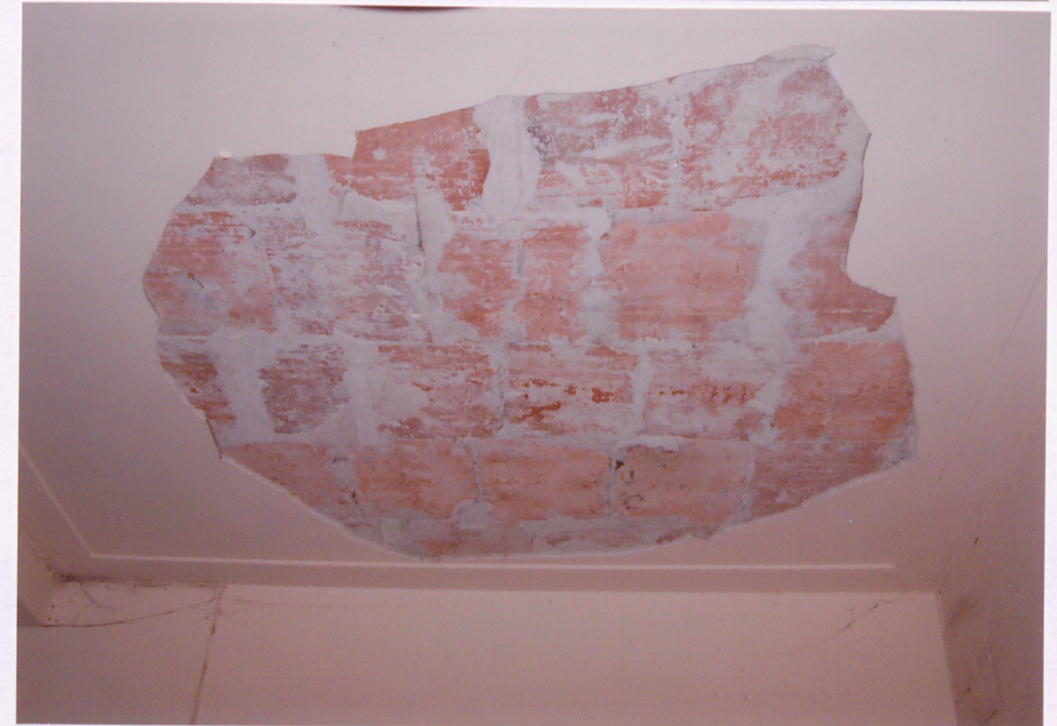
Fot. 24. Braki tynku sufitu ukazujące strop Akermana.
