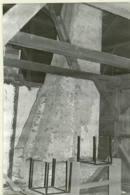
PION SPALINOWY W OBRĘBIE PODDASZA
