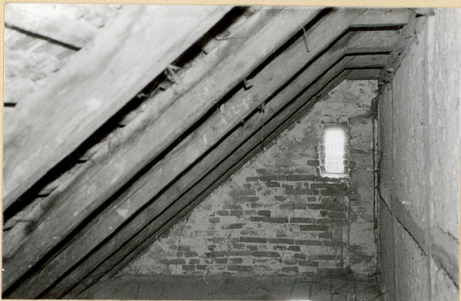
Więźba dachowa i ściana rygłowa na poddaszu nad częścią północną rzędcówki
