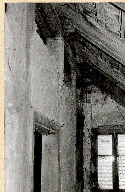
Ściana ryglowa na poddaszu nad stołówką
