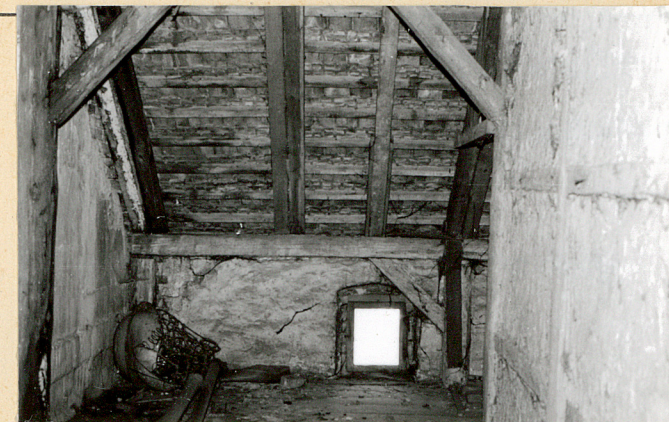
Poddasze z widoczną ścianką kolankową
