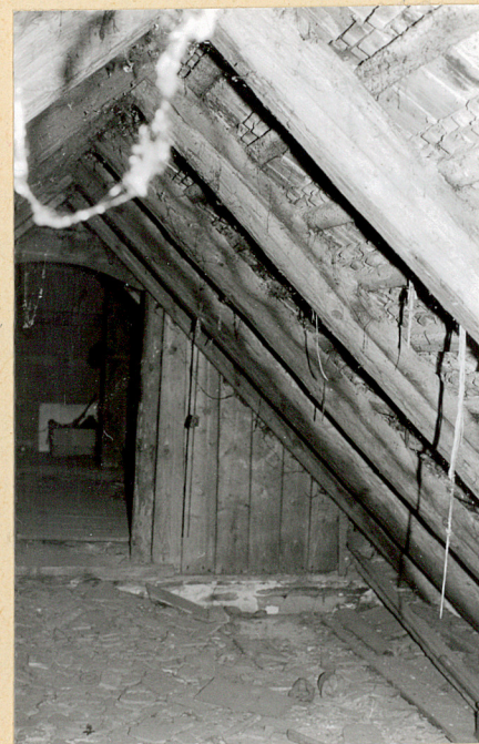
Więźba dachowa ( dach nad przewiązką )
