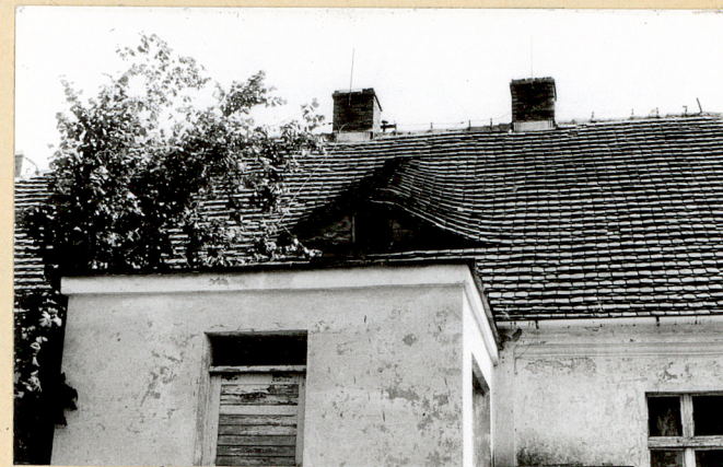
Fragment północno-zachodni połaci dachowej z "Wolim okiem"
