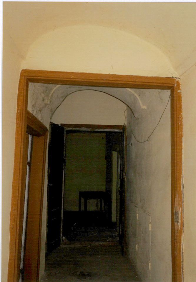
Fot.22 Sklepienie kolebkowe na gurtach w sieni.
