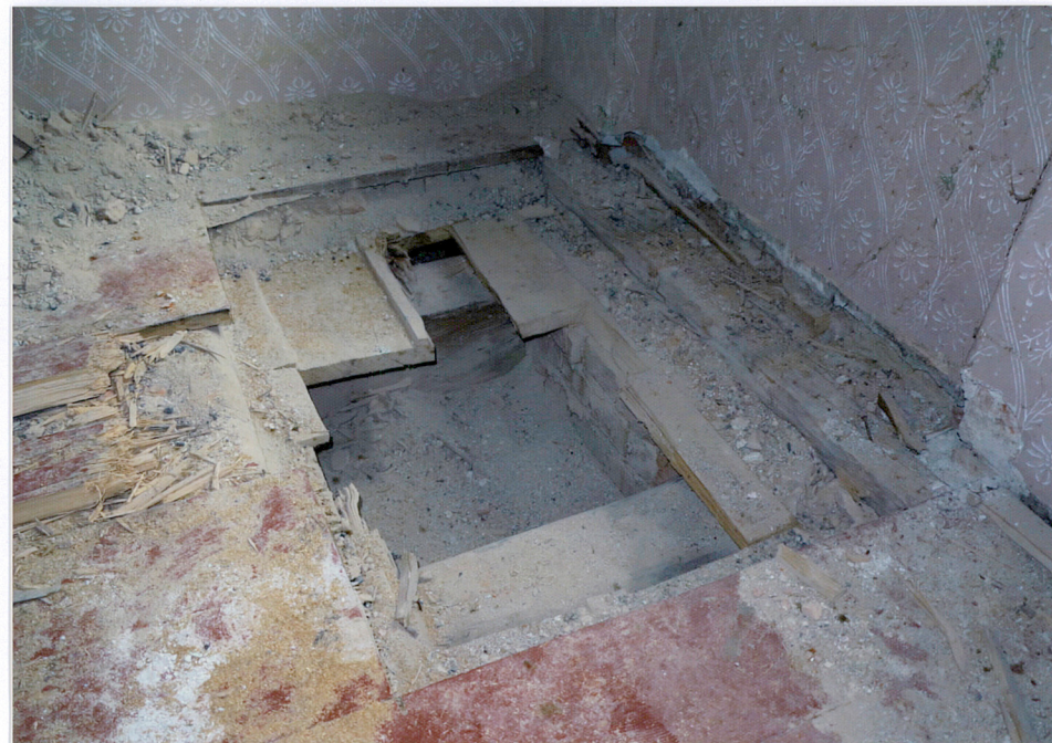
Fot.14. Odkrywka z widocznymi drewnianymi belkami stropu.
