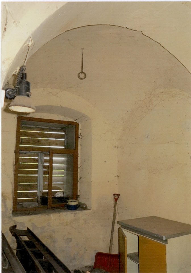
Fot.21. Sklepienie żaglaste.
