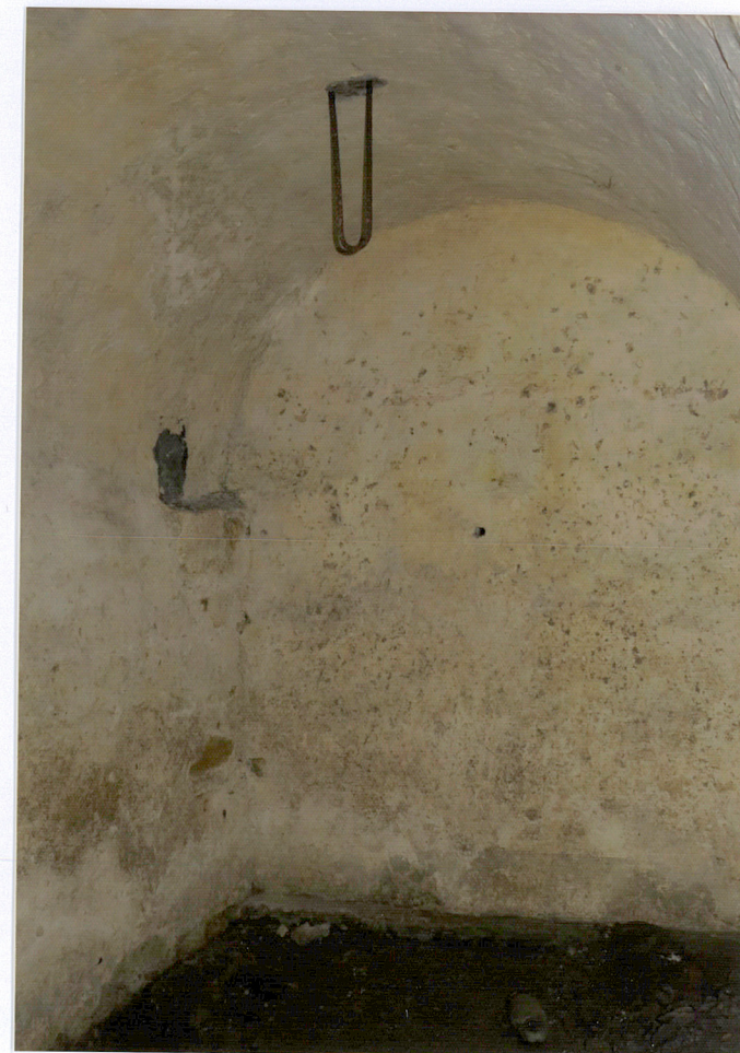
Fot.28. Sklepione kolebkowo pomieszczenie piwnic.
