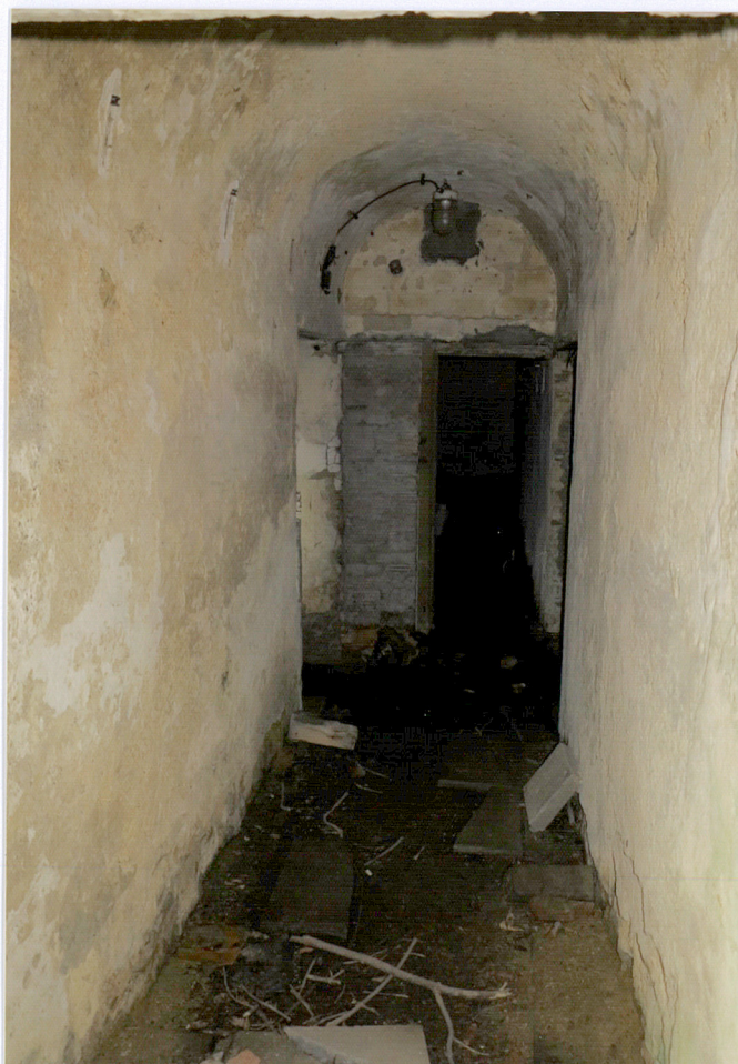
Fot.27 Sklepienie kolebkowe w obrębie piwnic.
